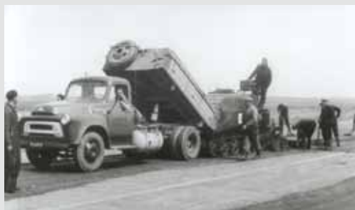
Asfalt lossen voor landingsbaan Schiphol
