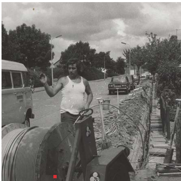
Aanleg kabeltelevisie in de Purmerstraat, Hoofddorp
