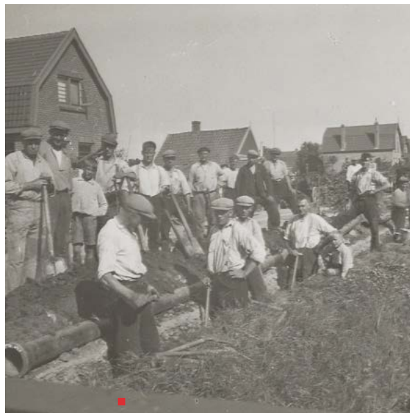
Aanleg gasleidingen aan de Wilgenlaan, Zwanenburg
